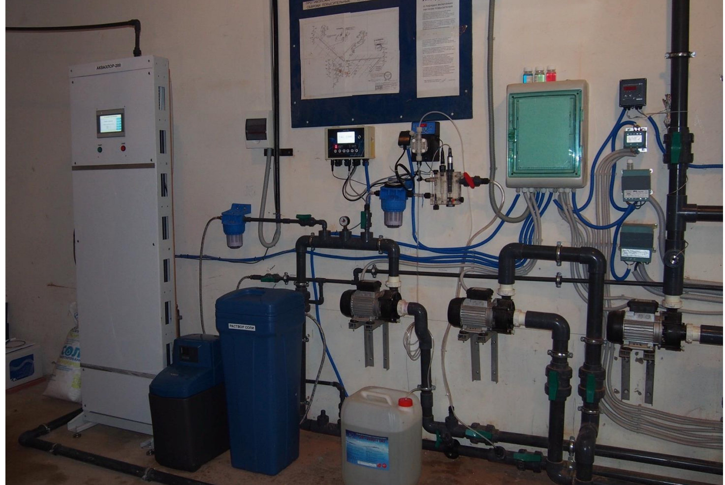
Установка АКВАХЛОР-200 в плавательном бассейне (900 куб.м), г. Зеленоград, 2017
