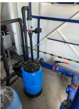
Установки ИЗУМРУД-Универсал-Турбо в быстровозводимых павильонах систем водоснабжения в малых поселениях республики Хакасия. 2024.
