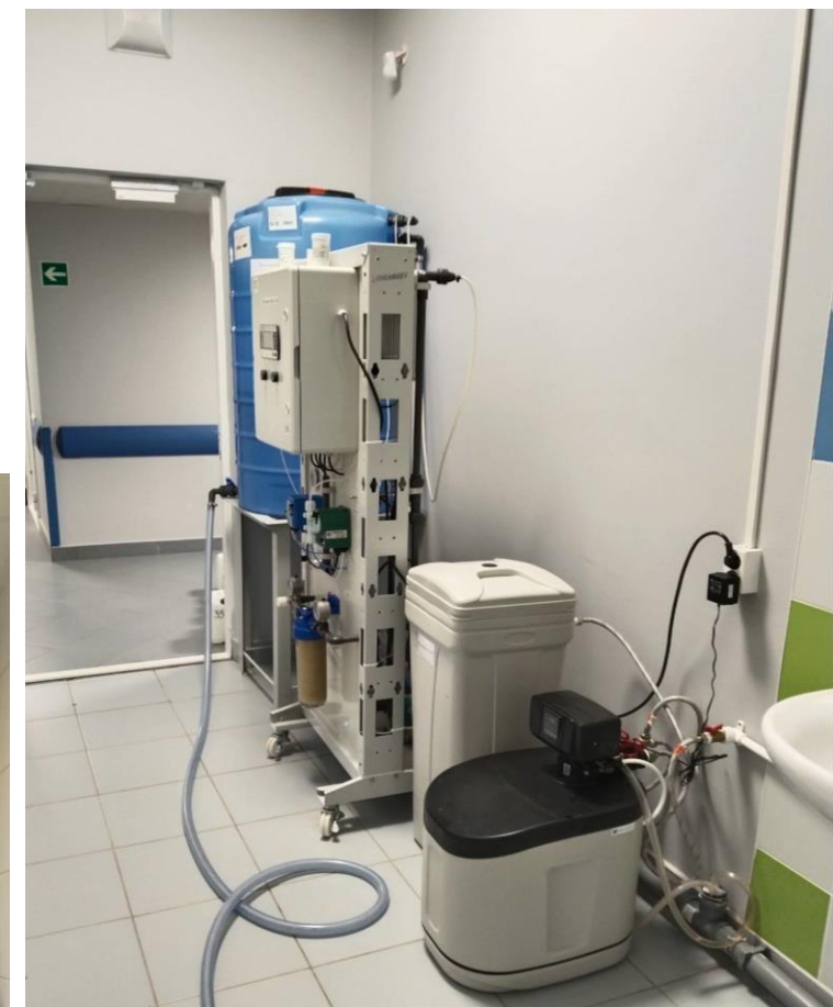
Установка СТЭЛ-АНК- СУПЕР-250 с умягчителем воды, баком для раство- рения соли и емкостью для Анолита АНК Супер в ГБУЗ «Государственная Новоси- бирская областная клини- ческая больница», 2024
